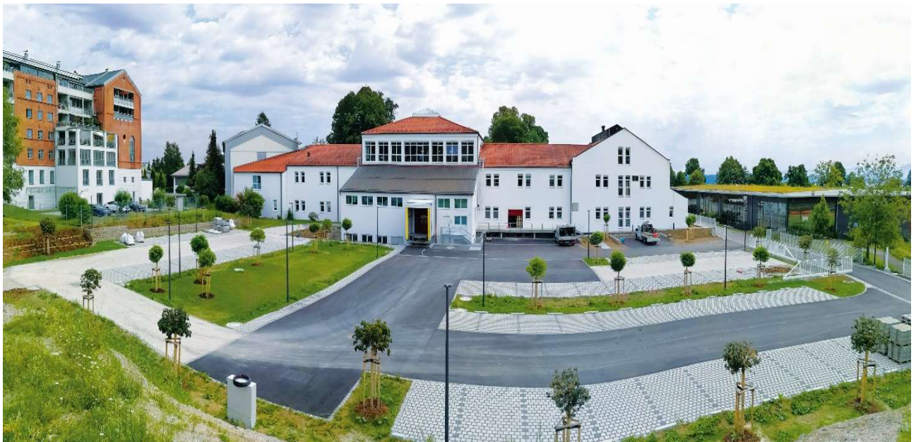
Rückansicht Gebäude Bernrieder Straße 1 mit LKW Andockstelle, neuen Parkplätzen und Grünanlagen. Bild © Verla-Pharm
